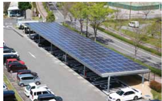
太陽光発電設備整備及び院内照明LED化 平成27年1月
