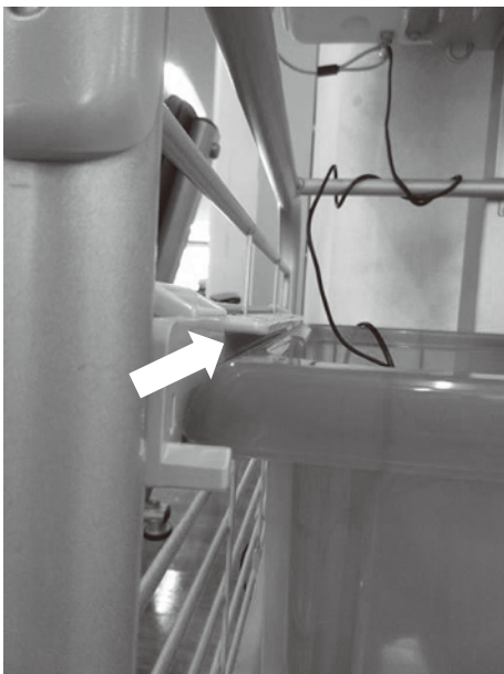
ケースとの隙間がありガタツキ音が発生
